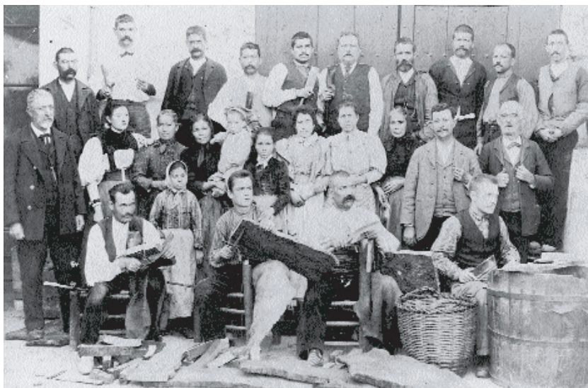
Treballadors d'una fàbrica de taps de Llagostera (no identificada). En primer terme veiem tres treballadors amb ganivets de fer llesques. Al seu costat, a la dreta assegut, i a la filera de dalt, alguns treballadors duen el ganivet de fer carracs. Abans de la mecanització els carradors eren un dels oficis més ben considerats en el món de la fabricació dels taps de suro. (Fons de la família Roqueta)
