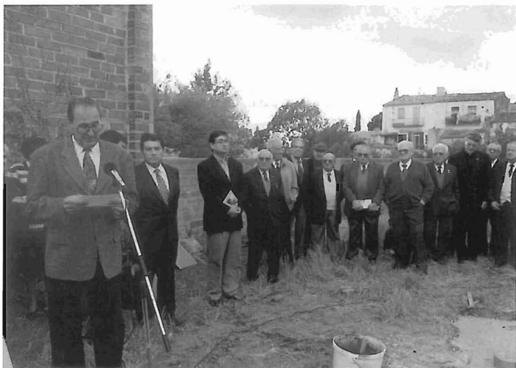
Col·locació de la primera pedra de la futura nova llar dels jubilats el 23 d'abril de 1995.
