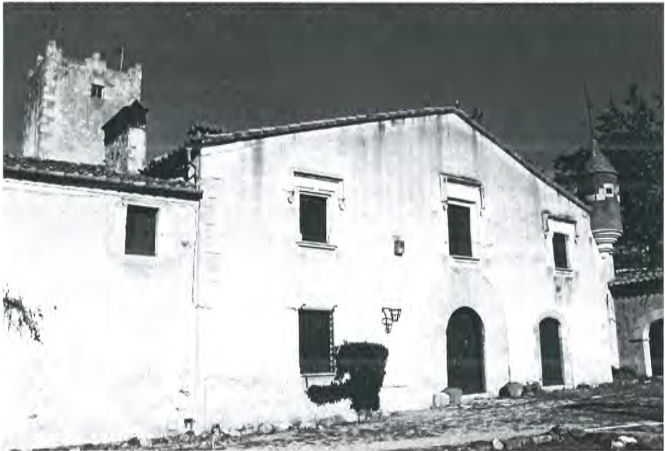
La torre Albertí, casa pairal dels procuradors del baró de Llagostera.
