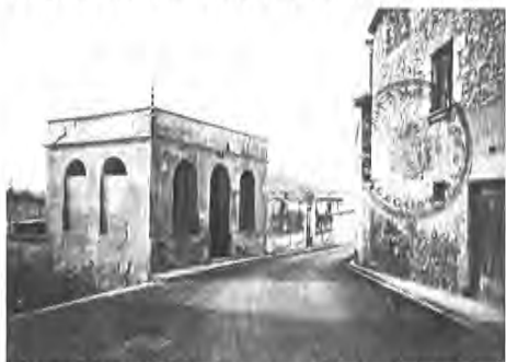
Antic edifici de la peixateria del carrer Alt de Girona.
