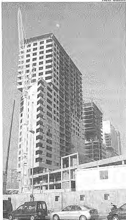
Filera d'hotels i blocs d'oficines que s'estan construint a pocs metres del recinte Forum
