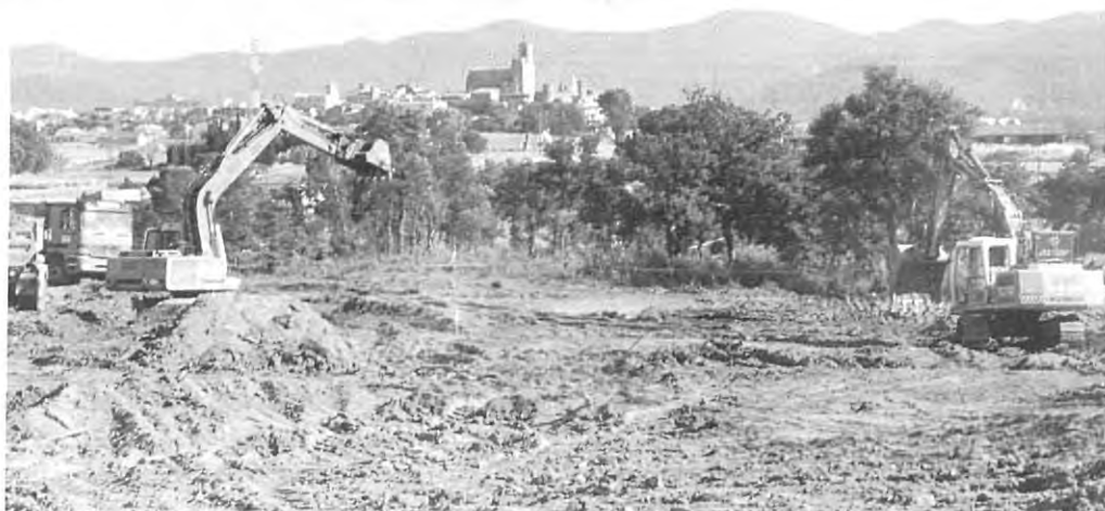
Màquines treballant a l'accés nord de la futura variant
