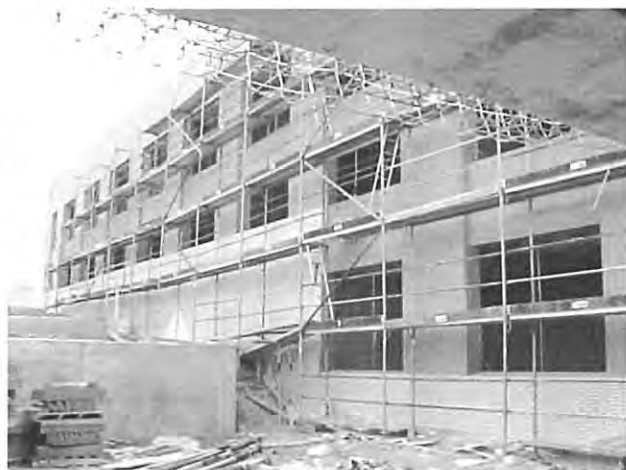
Les obres de l'IES
