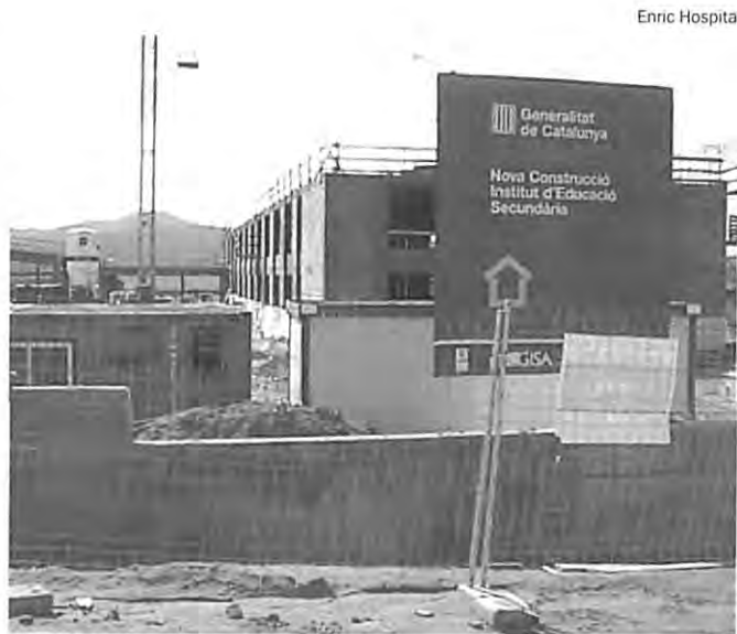
Obres de construcció de l'IES Llagostera
