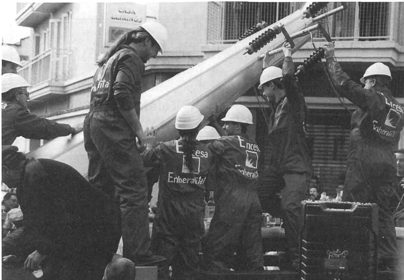
Operaris d'Encesa tirant a terra una torre de la línia de les Gavarres
