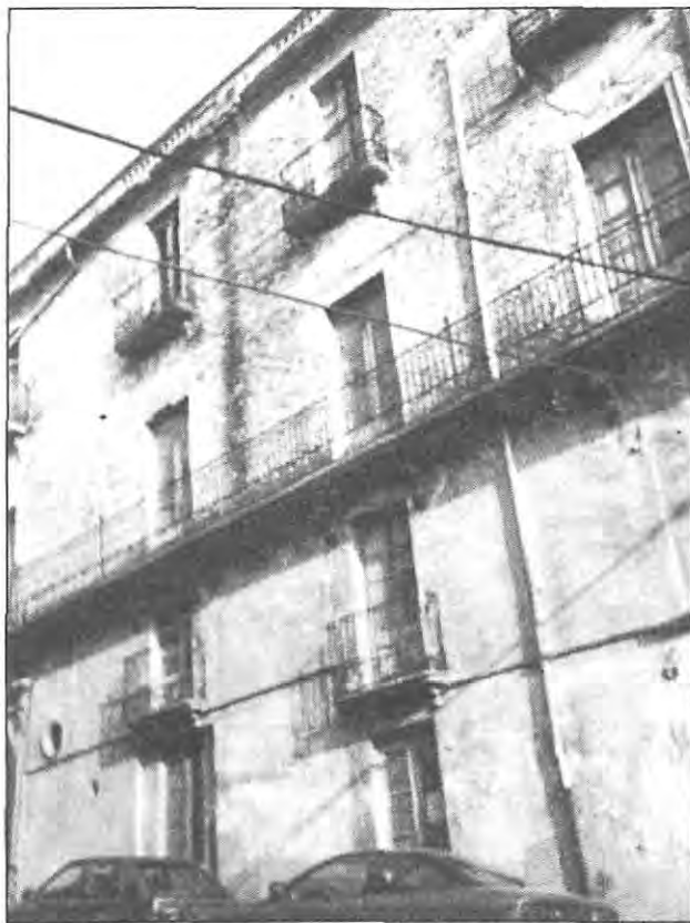
El conjunt de Can Caldes és un edifici tan singular com ruïnós. Foto: Jordi Moll
