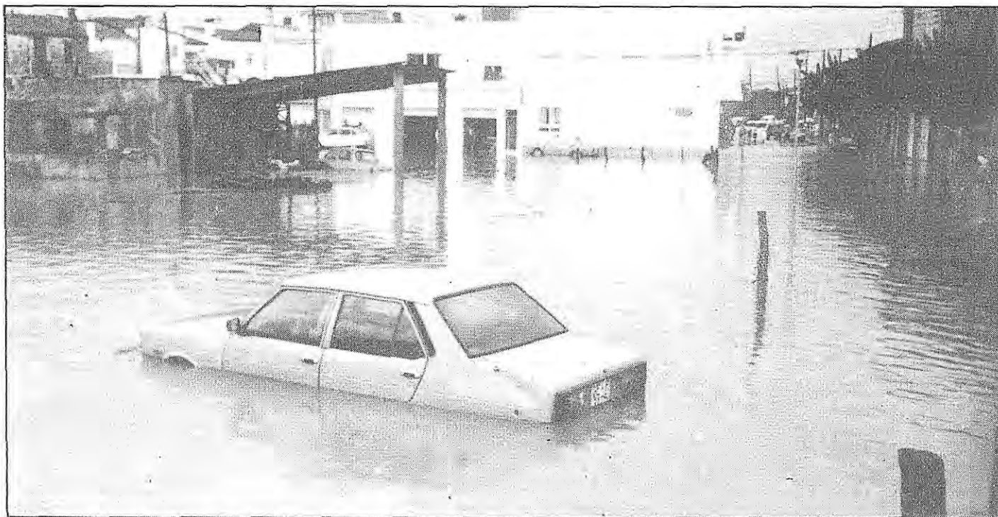
Les pluges dels primers dies d'octubre van desbordar la Gotarra, inundant tot el sector del Carrilet i carrers adjacents. A la fotografia el passeig Romeu.
