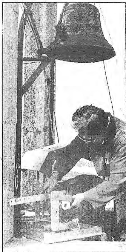
El rellotger Joan Fabra instal·lant el motoret del martell dels quarts.
