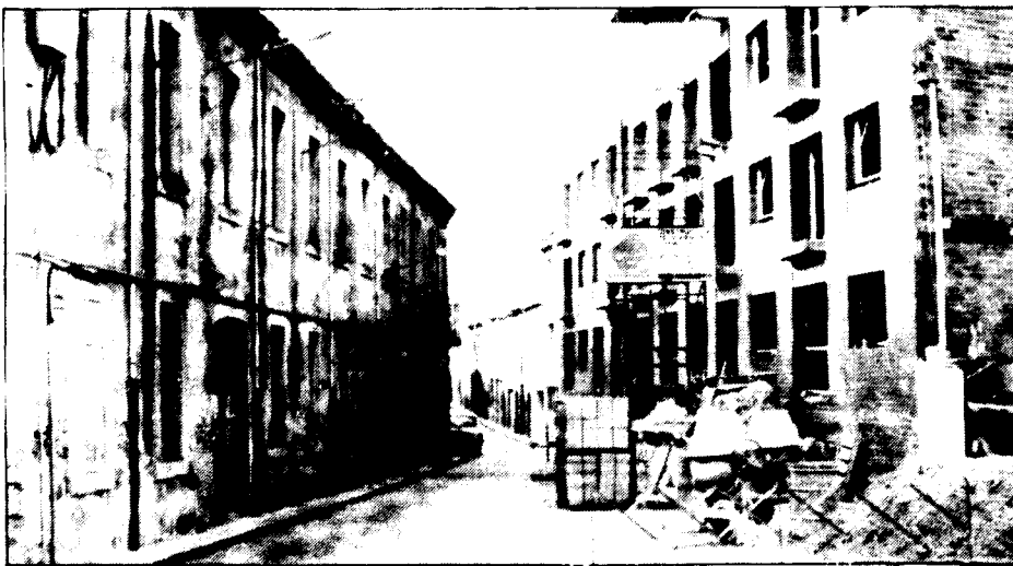
Mentre la fàbrica de les Agulles ha tancat les portes, al davant s'està construint.
