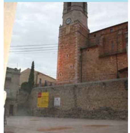
Les obres de la primera fase ja estan acabades.
