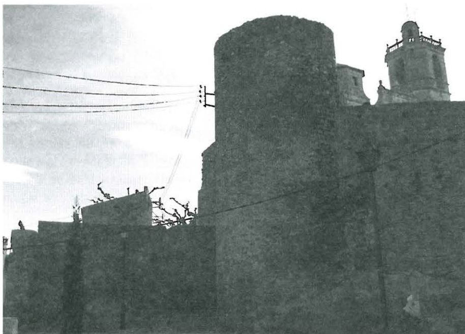
Estat actual de la Muralla al carrer Processó
