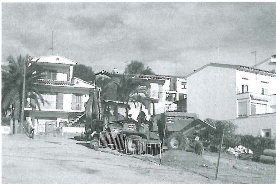
Obres d'urbanització del Puig del General
