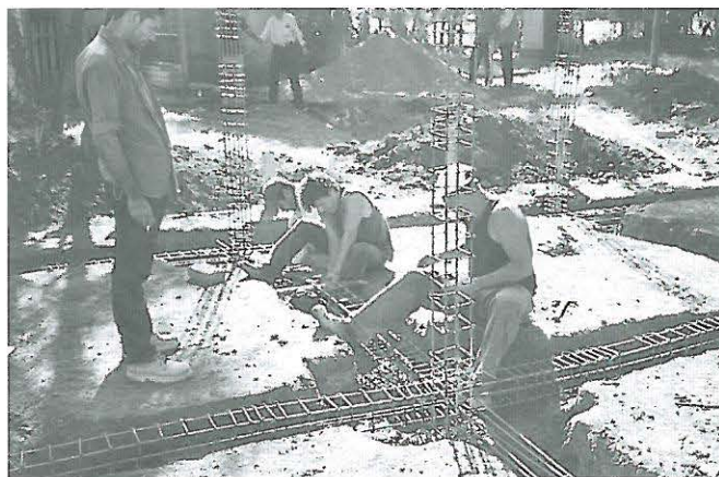
Treballs de construcció del banc de gra a San Nicolás de Oriente
