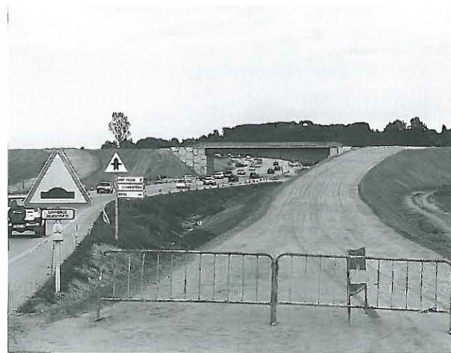
Obres a la C-253, a la cruïlla de Tossa. Foto F. Solà.
