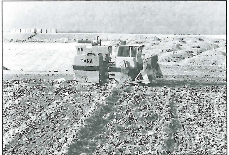
Màquina Tana compactant les escombraries.
