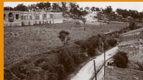
Vista del carrer Ganix l'any 1955. Sota el dipòsit de les aigües, l'estructura de l'edifici de les escoles del Puig es mantenia igual que en acabar la guerra.
