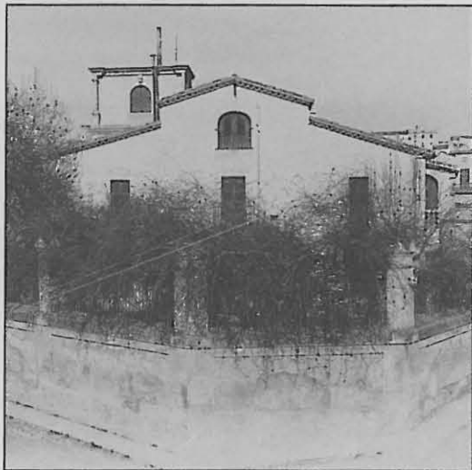
Façana sud de la casa pairal d'Antoni Romeu.
