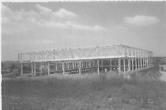
Maig 1990. Pavelló Municipal d'Esports en construcció.
