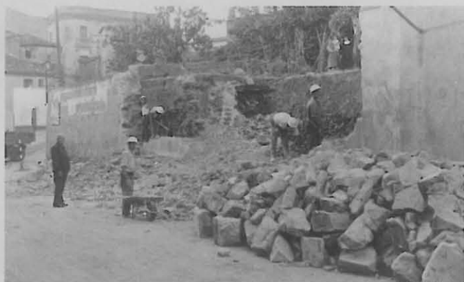
Josep Milán visitant les obres del nou pavelló (1967. AMLLA Foto Vall-llosera)-.
