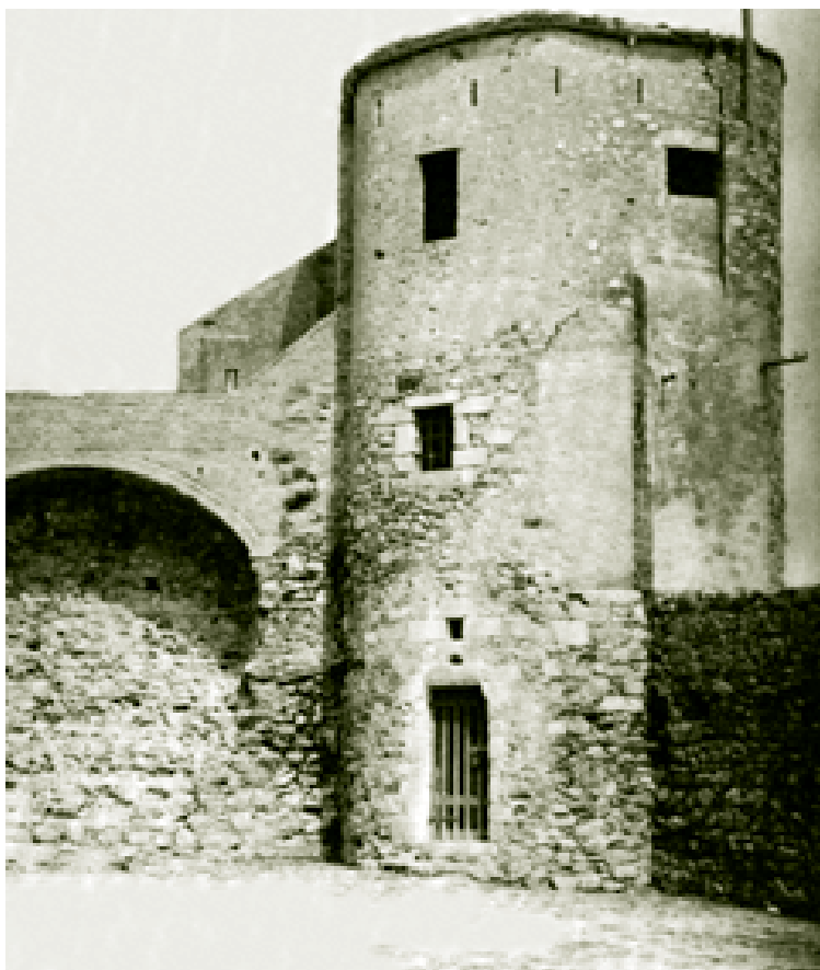
Figura 6.3. Imatge antiga de la torre de la Presó des de l'interior del recinte. La part superior, amb les dues finestres i el rengle d'espitlleres, és un afegitó modern, potser del segle XIX, que fou enderrocat posteriorment.
