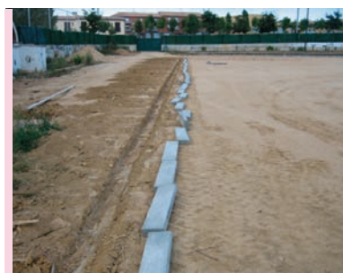
Diferents vistes de les obres del camp
