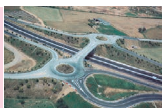
Vista aèria de la nova carretera.
